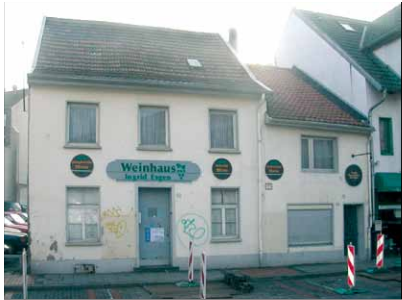
Abb. 13: Hamtorstraße 30. Das Gebäude vor dem Abriss.
