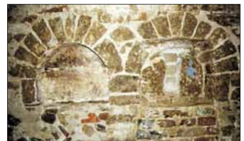
Abb. 2: Niederstraße 47–49. Freigelegtes romantisches Doppelbogenfenster.
