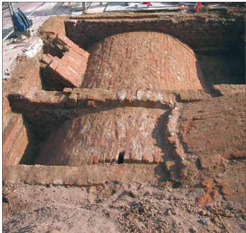
Abb. 14: Hamtorstraße 30. Nach dem Abriss des Hauses freigelegtes Kellergewölbe.
