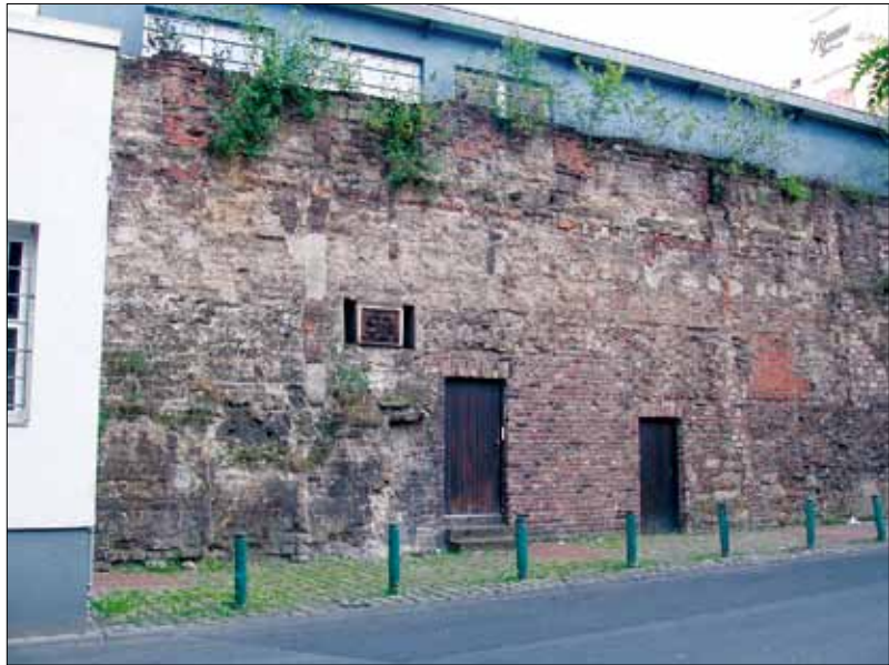
Abb. 2: Stadtmauer an der Untermauerstraße mit vorromanischem Mischmauerwerk.
