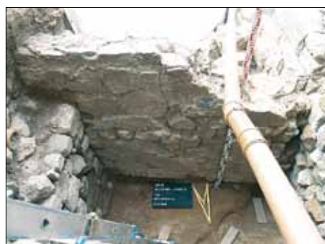
Abb. 9: Das Mauerwerk des südlichen Seitenschiffs mit Fundament und der untersten Lage des aufgehenden Mauerwerks.
