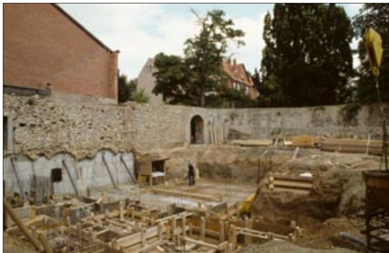
Abb. 2: Der Schulneubau nimmt einen Teil der Stelle der ehemaligen Stadtburg ein, die im Winkel der Inneren Stadtmauer platziert war. Die Mauer wurde ins neue Gebäude integriert.
