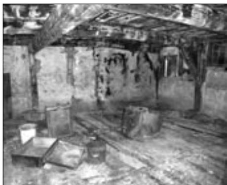
Abb. 14: Brandenburg, Altstadt, Bäckerstraße 14, erstes Obergeschoss, rückwärtiger Raum, Blick zur hofseitigen Giebelwand. Vollständig original erhaltener Innenraum mit Wandständern, im Raum sichtbaren Kopfbändern, Unterzug und Lehmausfachungen, Rauchabzug an der Giebelwand, Kalkung wohl 18. Jahrhundert, Fenster 19. Jahrhundert (Fotomontage 2006).
