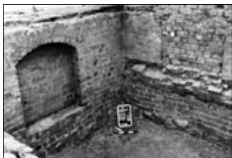
Abb. 2: Hauskeller in der Saugasse. Der vermauerte ältere Zugang deutet die Zweiphasigkeit des Kellers an, während das unmittelbar darunterliegende Gewölbe Bestandteil der jüngeren Bauphase war.
