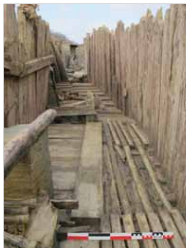
Abb. 7: Teilabschnitt des Stollens mit Laufrost aus Holz.
