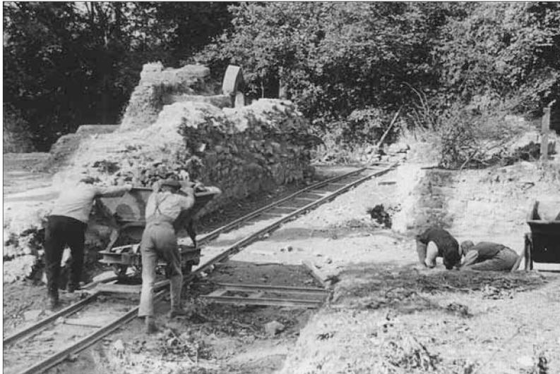
Abb. 10: Burg Vlotho. Enttrümmerungsarbeiten auf dem Gelände der Burg. Eingesetzt werden Kipploren im Handverschub.
