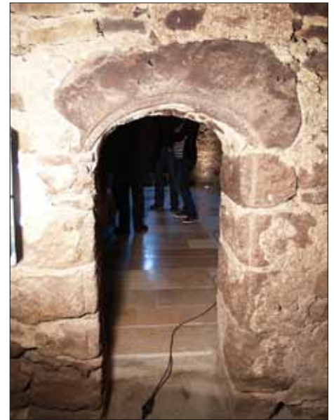
◁ Abb. 6: Blick auf die Trennwand aus Phase 2 mit segmentbogiger Tür.
