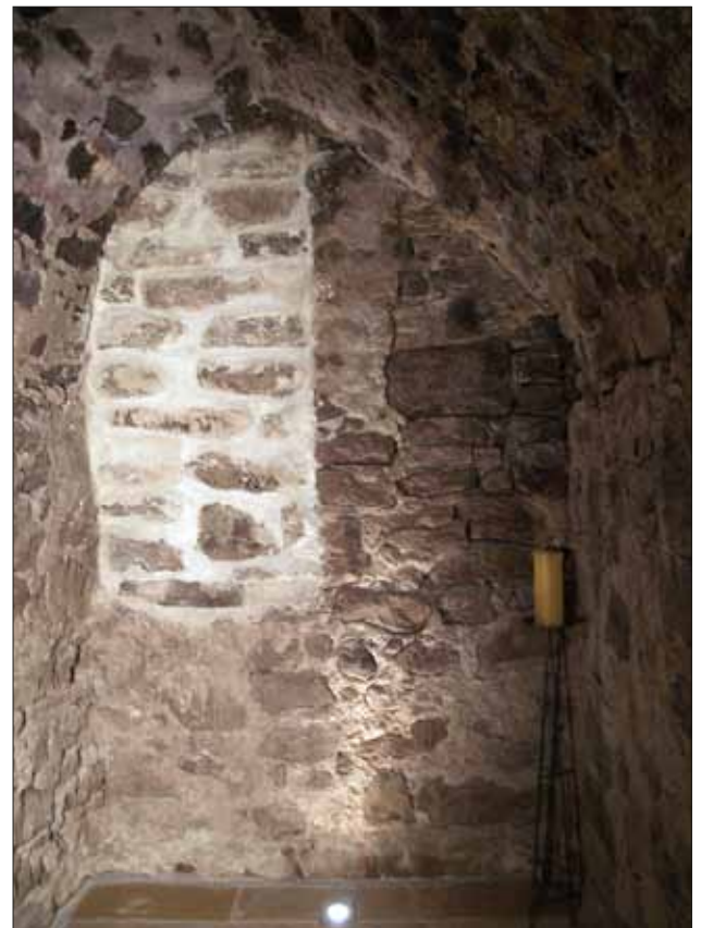
▽ Abb. 9: Westliche Schmalseite Kellerraum 2 mit zugemauertem ehemaligem Zugang zum Tauchbad.
