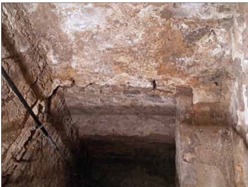
Abb. 4: Blick in das Tauchbecken der Schachtmikwa mit Grundwasser.
