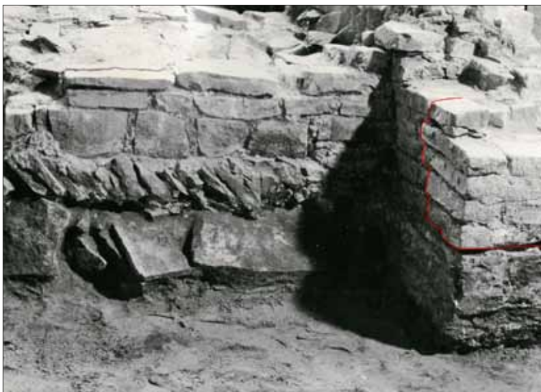
Abb. 14: Grabung 1956. Wandvorlage an der Ostwand, nördlich des Altars. Die Linie markiert die Baunaht mit dem erneuerten Eckbereich.
