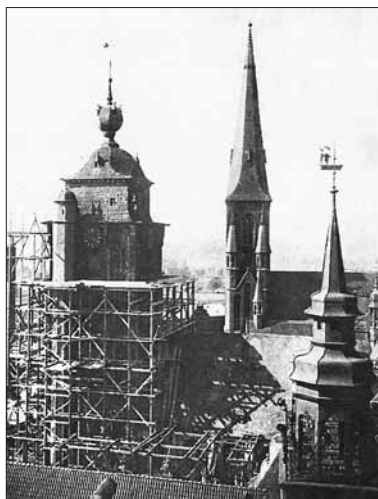
Abb. 4: Eingerüsteter Westturm zu Beginn des Umbaus, ca. 1897. Im Bildhintergrund der Turm der Liebfrauenkirche.
