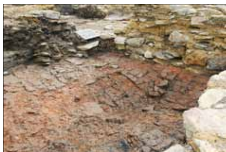
△ Abb. 4: Fußbodenfliesen im südlichen Kreuzgang, die sich durch altbergbauliche Hinterlassenschaften abgesenkt haben.
