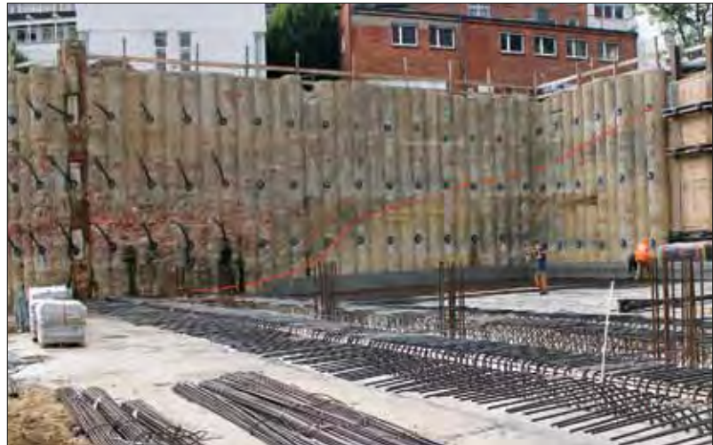
Abb. 6: Auf der Bohrpfahlwand am Wehdehof ist der Abdruck der archäologischen sowie geologischen Schichten als auch der extreme Höhenunterschied gut zu erkennen.
