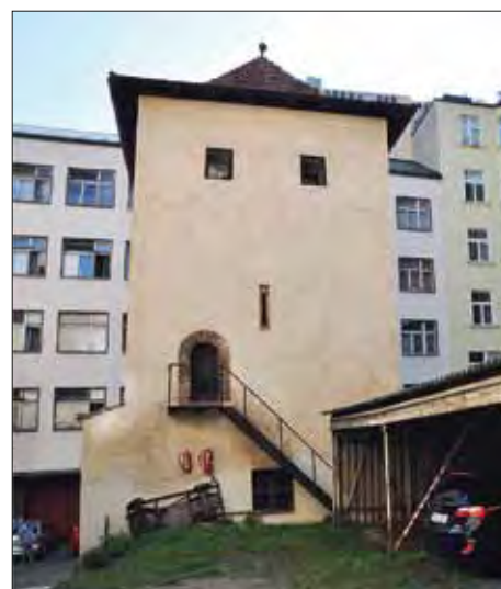
Abb. 3: Der erhaltene rechteckige Turm der Altstädter Befestigung im Hof des Anwesens Bartolomějská-Straße Nr. 310.
