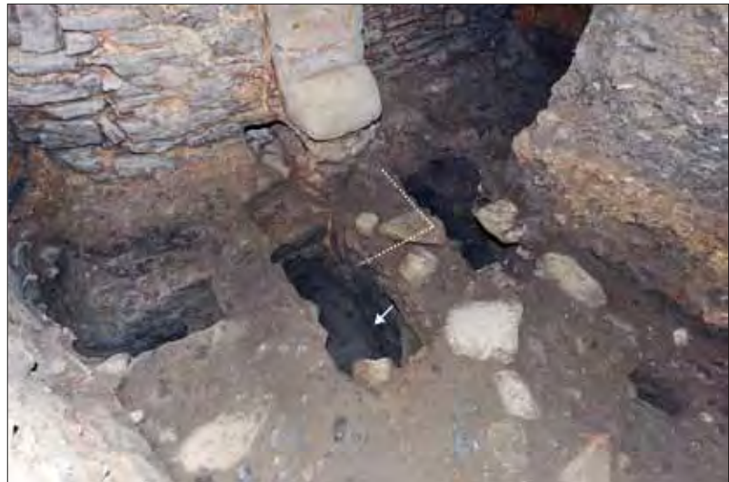
Abb. 18: Südliche Laibung des ehemaligen Valentin-Tors mit dem vermauerten Balkenlager an der westlichen Oberseite und der Eichenschwelle des Tors (nach 1239d) in der Křižovnická-Straße Nr.71.
