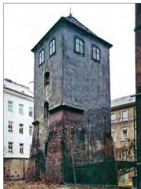
Abb. 4: Der erhaltene rechteckige Turm der Altstädter Befestigung im Hof des Hauses Nr. 314 in der Bartolomějská-Straße.
