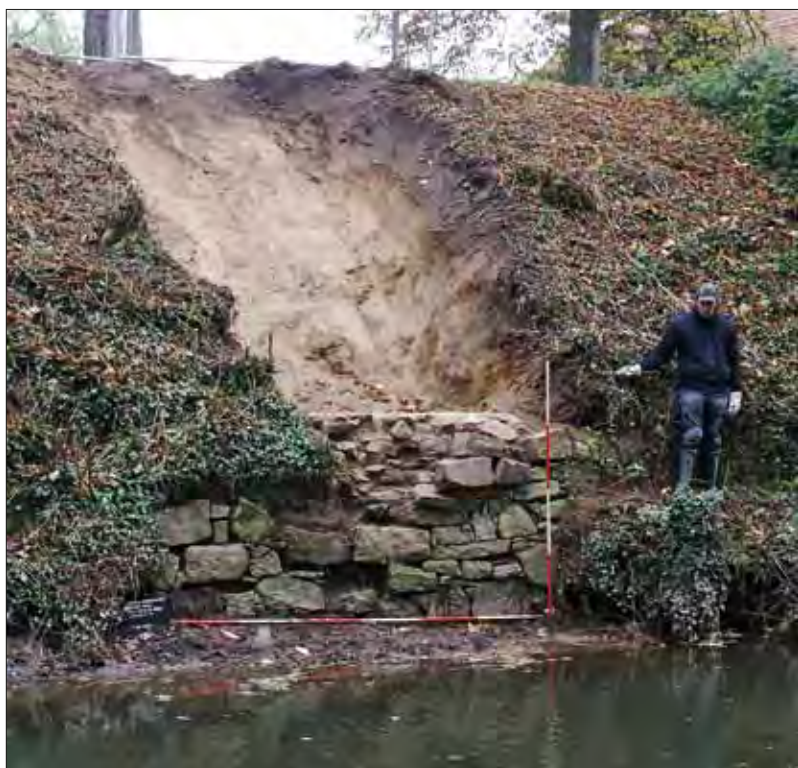
Abb. 6: Schuhmacherwall (heute Hoher Wall). Blick auf die freigelegte Mauer mit dem darüber liegenden Wall. In diesem Bereich dürfte nur noch eine 1,2–1,7 m hohe Brustwehr fehlen.
