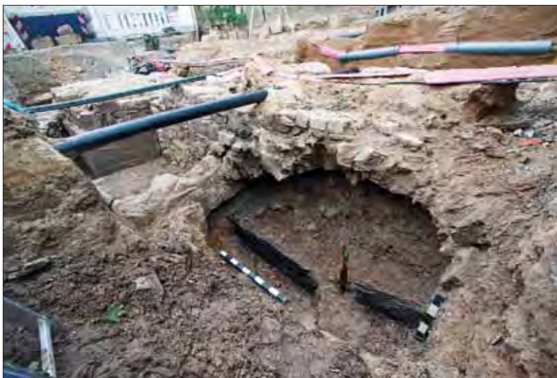
Abb. 8: Langenbrücker Tor. Der Wassergraben vor dem Torturm (Quadermauerwerk, links) aus der zweiten Hälfte des 13. Jahrhunderts wurde im Zwingerbereich durch einen 3 m breiten Kanal geleitet.
