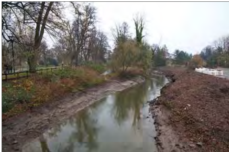
Abb. 5: Kaufmannswall (heute Lindenwall). Blick auf den Zusammenfluss von Bega (rechts) und dem Stadtgraben, der weiter im Osten durch die Bega gespeist wurde. Der Wallkörper (links) wurde um etwa 2 m abgetragen.
