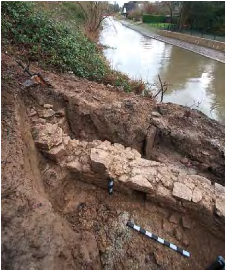
Abb. 9: Schusterrondell. Blick auf die partiell freigelegte Geschützstellung mit dem anschließenden Schuhmacherwall in Richtung Langenbrücker Tor. Rechts des 0,5 m-Stabs ist eine Entwässerungsöffnung zu sehen und Reste der in ein 0,5 m starkes Kalkmörtelpaket gelegten Pflasterung.
