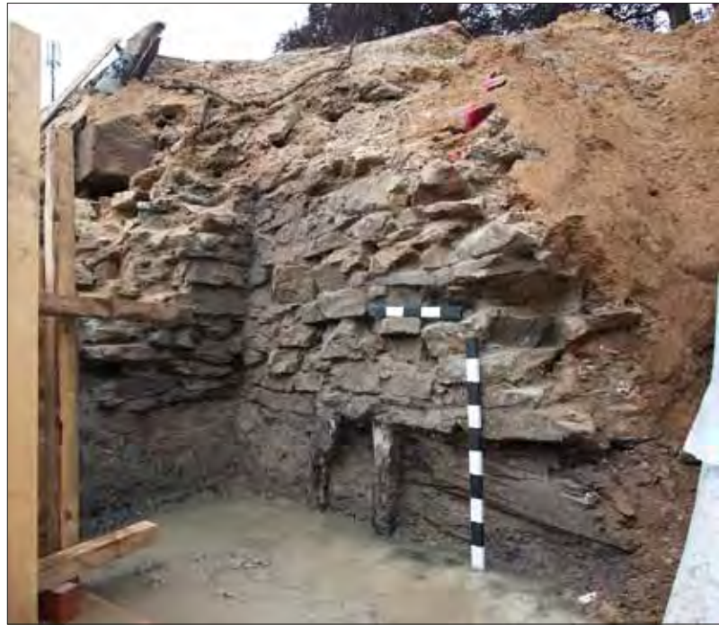
Abb. 3: Langenbrücker Tor. Fundamente des im 16. Jahrhundert innerhalb des Vorwerks errichteten Turms. Zu sehen ist eine eher abenteuerliche Mischung aus Rammpfählen und Resten eines Rosts.
