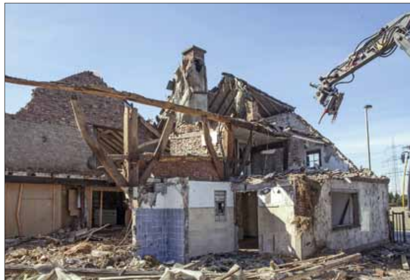
14 Duisburg-Kaldenhausen. Beim Abbruch des Hauses Traarer Straße 63 entdecktes Kerngerüst eines Bauernhauses von 1615 d.
