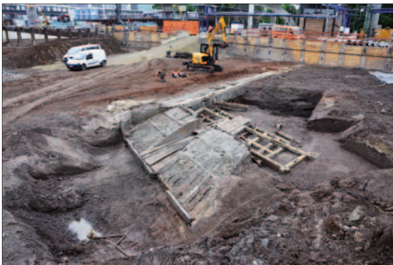
10 Stuttgart, Mittlerer Schloßgarten. Stauwehr des 16. Jahrhunderts.
