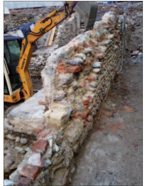
6 Die Brandmauer des Hauses „Zum Gieren“ (Steinenvorstadt 40) während des Abbruchs 2017. Gut erkennbar sind in der dünnen Mauer die Lagen von Backstein und Wacken in regelmäßigem Wechsel mit Querbindern.
