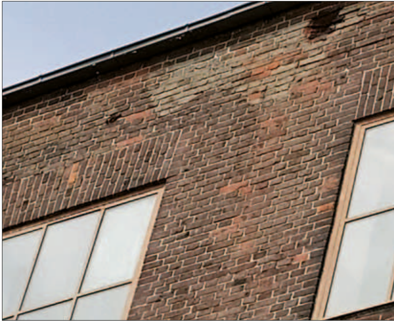
16 Einschlagkrater eines Bombensplitters in Peenemünde in einem Gebäude der V-Waffen-Versuchsanstalt.
