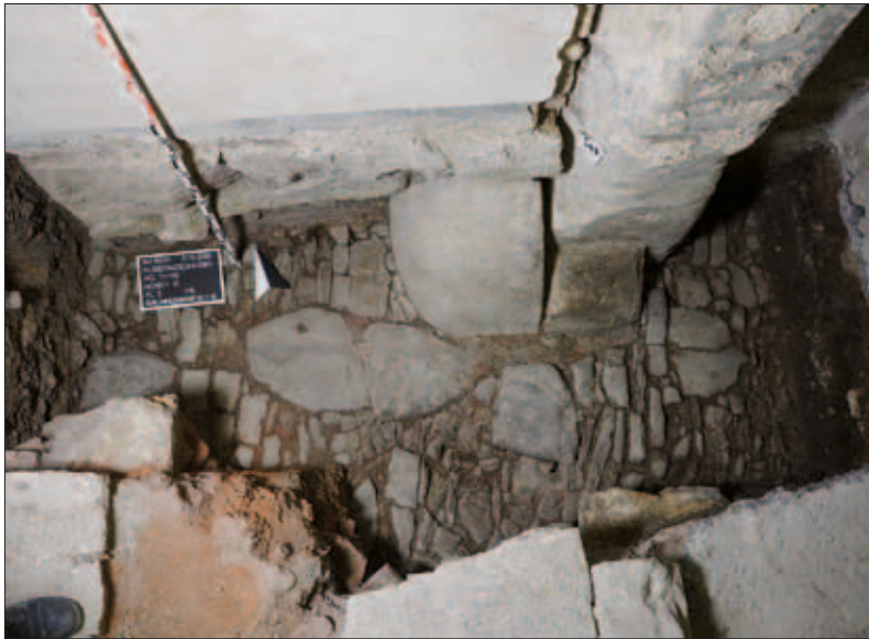
13 Tordurchfahrt in der Westwand des Grünen Hauses. Der Radabweiser wurde erneuert. Im Pflaster ist die von den Kutschen eingefahrene Rinne zu erkennen.
