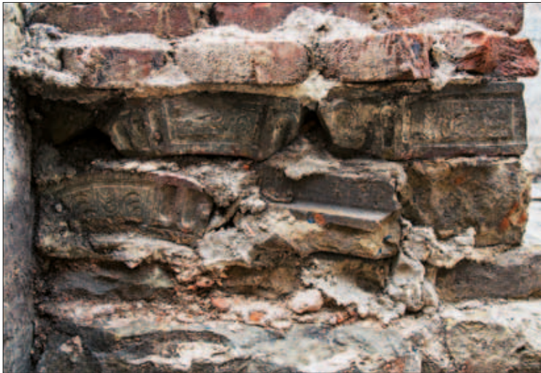
16 Im Stil der Weserrenaissance verzierte Fasadensteine, verbaut in das Fundament von um 1741 neu errichteten Wohnhäusern östlich der Großen Weserbrücke. Die Spolien stammen vermutlich von bei der Explosion der Braut 1739 beschädigten Häusern.
