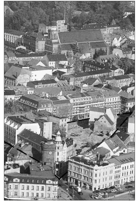
Abb. 2 und 3: Genordeter Ausschnitt aus dem Handschky-Plan (siehe Abb. 1) mit dem Gebiet der archäologischen Untersuchungen und Luftbildaufnahme des Quartiers während der Untersuchungen 1994; im Vordergrund der Turm des Spremberger Tors und im Hintergrund die Oberkirche, dazwischen das Untersuchungsgebiet (mit gestrichelter Linie markiert).
