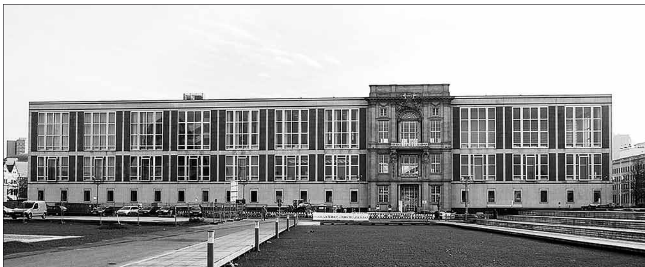
Abb. 1: Gesamtansicht des Staatsratsgebäudes 2005.
