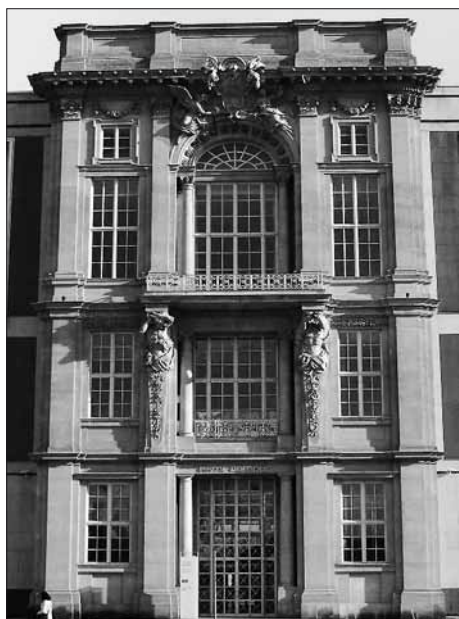
Abb. 2: Detail der Portalachse am Staatsratsgebäude.
