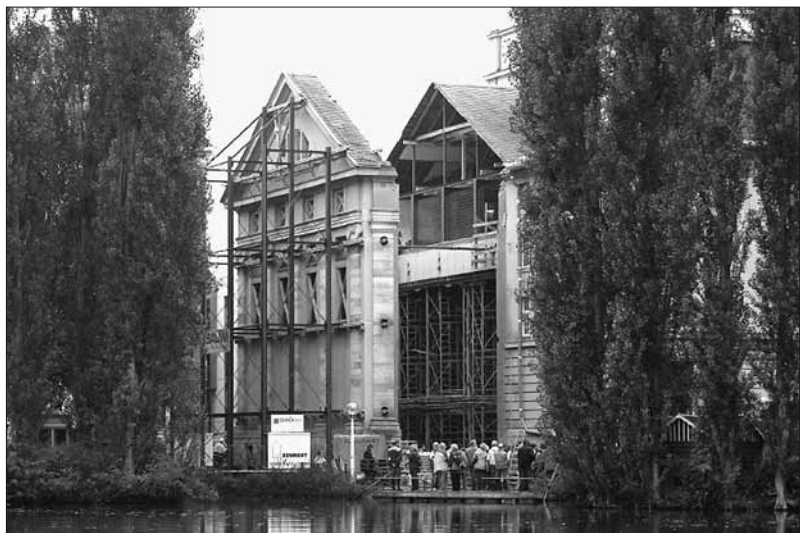
Abb. 11: Translozierung der Fassade des Meiningener Theaters.
