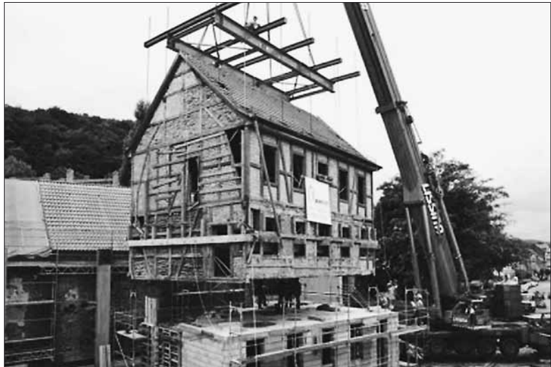
Abb. 10: Translozierung eines Fachwerkhauses.
