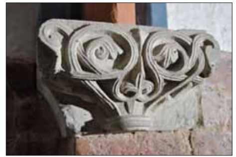
Abb. 14: Brandenburg, Dom St. Peter und Paul, Krypta. Nachträglich als Konsolkämpfer eingesetztes Dienstkapitell an der nordwestlichen Wandvorlage.
