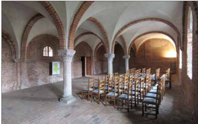
Abb. 18: Jerichow, ehemalige Prämonstratenserstift, sogenanntes Sommerrefektorium. Ähnlich könnten die Räume der Ost- und Nordklausur in Brandenburg ursprünglich ausgesehen haben.
