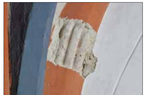
Abb. 15: Brandenburg, Dom St. Peter und Paul, Krypta. Freilegung des aus Formsteinen gemauerten Rippensprofils im nordöstlichen Gewölbejoch.
