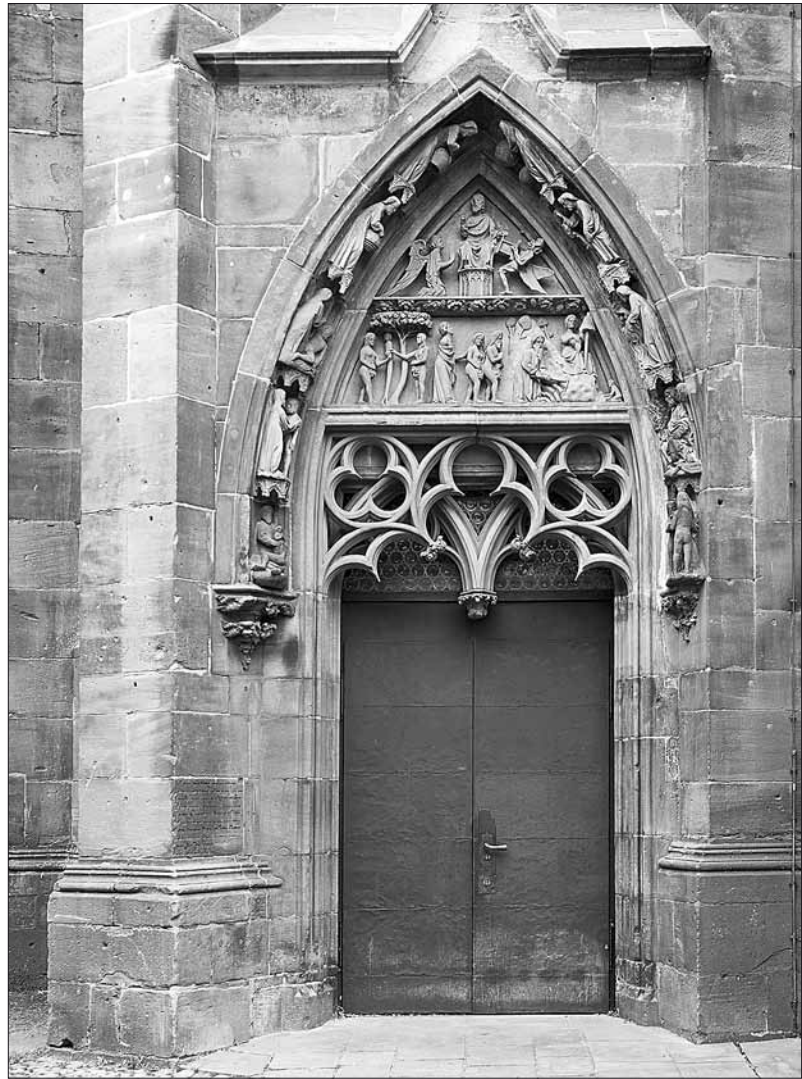
Abb. 1: Das Schöpfungsportal des Freiburger Münsters zeichnet sich durch ein reiches Bildprogramm aus und bietet mit einem zweischaligen Aufbau und sich überlagernden Maßwerken eine eigenwillige Entwurfslösung.
