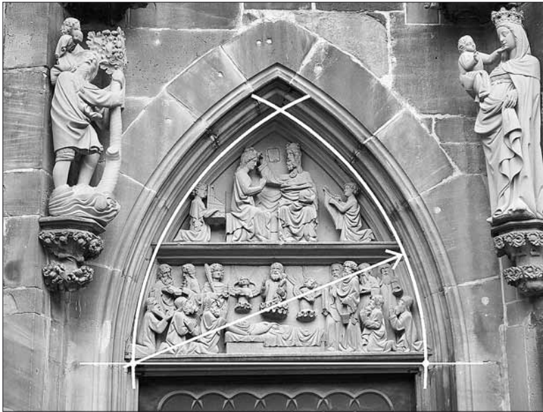
Abb. 9: Das Marienportal auf der Südseite des Chors mit der Darstellung von Tod und Krönung Mariae, überlagert mit der Konstruktionsfigur des gleichseitigen Spitzbogens.
