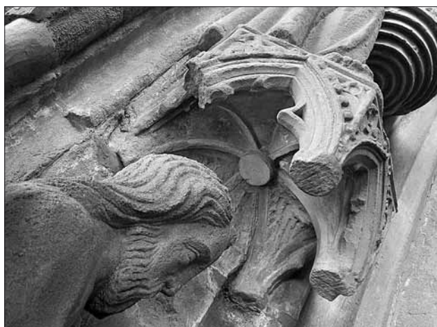
△ Abb. 7: Blick von unten in einen unvollendet gebliebenen Baldachin in der Archivolte, an dessen unteren Bogenenden noch Reste der Oberfläche des Rohblocks stehengeblieben sind.
