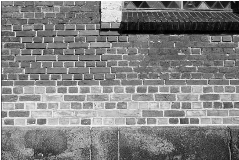
Abb. 12: Unter Wiederverwendung heller romanischer Backsteine aus dem Vorgängerbau errichteter Sockelbereich der Ratzeburger Stadtkirche von 1791.
