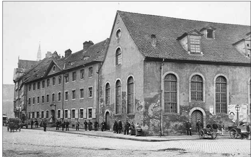
Abb. 7: Der 1745 errichtete Neubau des Hospitals St. Spiritus in der hannoverschen Schmiedestraße (links im Bild, Foto vor 1875).
