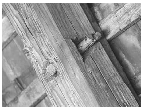
Abb. 3: Baubefund im Dachwerk der Andreas-kirche in Großbettlingen von 1497i mit erhaltenem Wiedenrest.
