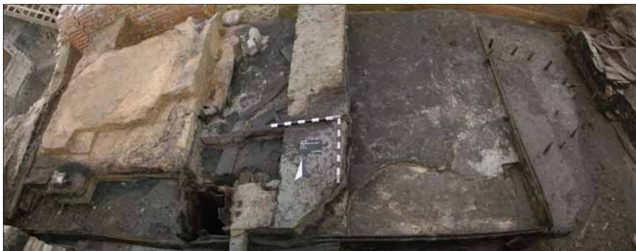
Abb. 2: Lübeck, Fischstraße 19. Wirtschaftsgebäude in Schwellbohlen-Konstruktion mit gesteckten Ständern und Spundwand.
