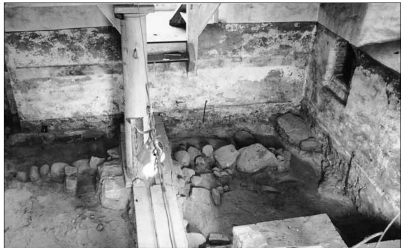
Abb. 3: Wolkenberg, Dorfkirche. Unterlegsteine der Fundamentierung einer hölzernen Vorgängerkirche des 14. Jahrhunderts im Befund.
