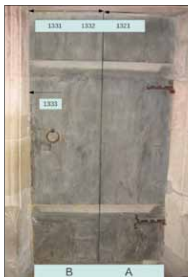
Abb. 9: Nördliche und südliche Lettnergertür (Nr. 8 und 9) in der Klosterkirche, Ansicht von Osten. Bezeichnung der Bohlen und Mess-Strecken.
