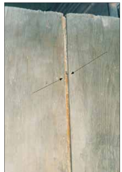
Abb. 3: Technologische Details an der südlichen Lettnergertür (Nr. 8): Auf der Rückseite von Bohle A ist ein Absatz im Faserverlauf das Relikt der Spalttechnik, nach unten verläuft der Absatz wieder in die Oberfläche. Auf der Vorderseite des Türblattes ist der Falz an der Bohle teilweise ausgebrochen und ein Holzdübel zur Fixierung der Bohlen sichtbar.
