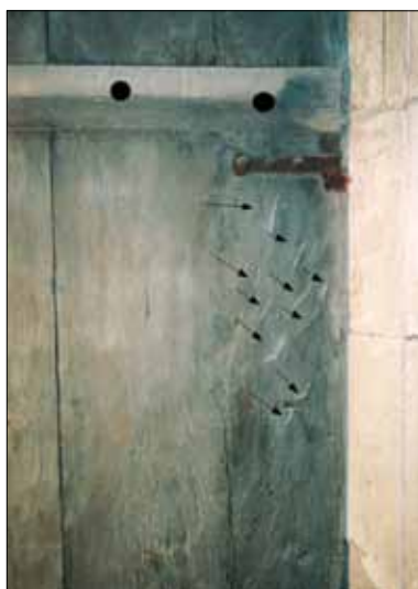
Abb. 4: Technologische Details an der nördlichen Lettnergertür (Nr. 9): Auf der Innen- und der Aussenseite des Türblatts sind die Bearbeitungsspuren mit dem Breitbeil deutlich erkennbar. Die Kanten der Schlag- und Hiebsspuren wurden teilweise mit Kreide eingefärbt. Pro Bohle wurden zwei Holz-Dübel (schwarz markiert) angebracht, sie fixieren die durchgehende, eingeschobene Querleiste.
