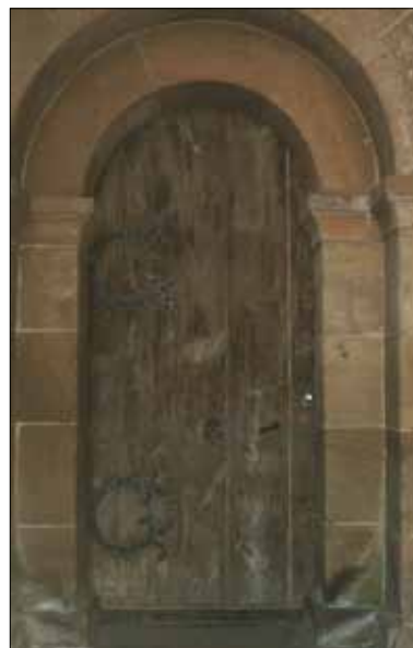
Abb. 13: Das neuzeitliche Tor des nördlichen Westportals der Klosterkirche (Nr. 3) von außen und innen. Bezeichnung der Bohlen und Mess-Strecken.
