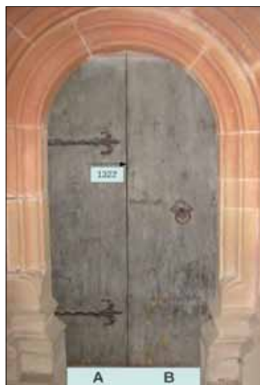
Abb. 8: Nördliche und südliche Lettnergertür (Nr. 8 und 9) in der Klosterkirche, Ansicht von Westen. Bezeichnung der Bohlen und Mess-Strecken. Die nördliche Lettnergertür ist älter und stammt wohl aus dem 13. Jahrhundert. Die südliche datiert in die zweite Hälfte des 14. Jahrhunderts.
