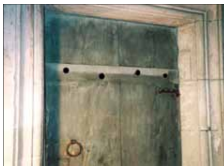
Abb. 4: Technologische Details an der nördlichen Lettnergertür (Nr. 9): Auf der Innen- und der Aussenseite des Türblatts sind die Bearbeitungsspuren mit dem Breitbeil deutlich erkennbar. Die Kanten der Schlag- und Hiebsspuren wurden teilweise mit Kreide eingefärbt. Pro Bohle wurden zwei Holz-Dübel (schwarz markiert) angebracht, sie fixieren die durchgehende, eingeschobene Querleiste.
