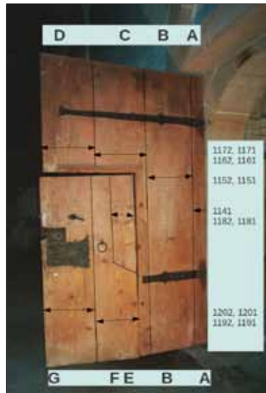
Abb. 12: Einflügeliges Tor mit Schlupftür (Nr. 5) aus der Zeit um 1500 im Südostjoch des Kreuzganges zur Herrenkirche von der Außen- und der Innenseite. Bezeichnung der Bohlen und Mess-Strecken.
