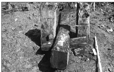
Abb. 16: Lübeck, Wallstraße 25–27. Die Verriegelung der Zuganker mit kurzem Querriegel im Inneren des Moor- oder Dreckwalls.
