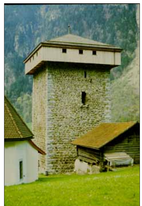
▽ Abb. 6: Mammertshofen, Kanton Thurgau (Zustand 1989). Der Megalithturm entstand 1230/40d. Während das heutige Ausmaß des Obergadens auf einen Umbau der Jahre 1421/30d zurückreicht, entstanden zwei Räume und ein zentraler Ofen bereits in der Zeit um 1330d.
