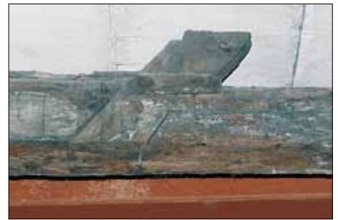
Abb. 6: Bielefeld, ehem. Franziskanerkloster St. Jodokus. Dachbalken mit angeblattetem Strebenrest.
