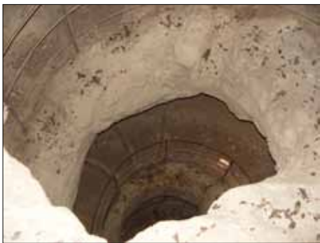
Abb. 7: Bakchissarai, Chufut Kale: Blick in den Schacht des Tiefbrunnens mit umlaufender Wendeltreppe.
