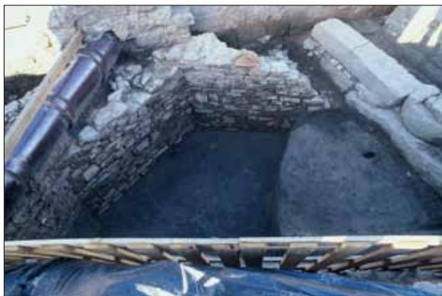
Abb. 8 (links): Staumauer mit stumpfwinklig ansetzender Stützmauer (der Betrachter schaut vom Ufer Richtung Seemitte, Neumarkt, 13. Jahrhundert).
