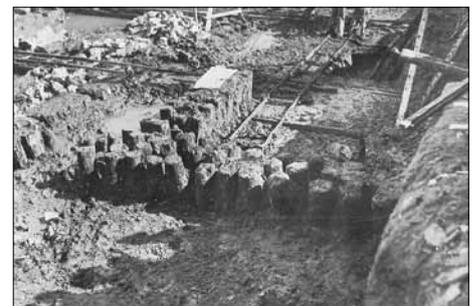
Abb. 12: Fundamentkonstruktion des mittelalterlichen Hauses am Damm, die nach dem kriegsbedingten Abriss des Gebäudes zu Beginn der 1950er Jahre dokumentiert werden konnte.
