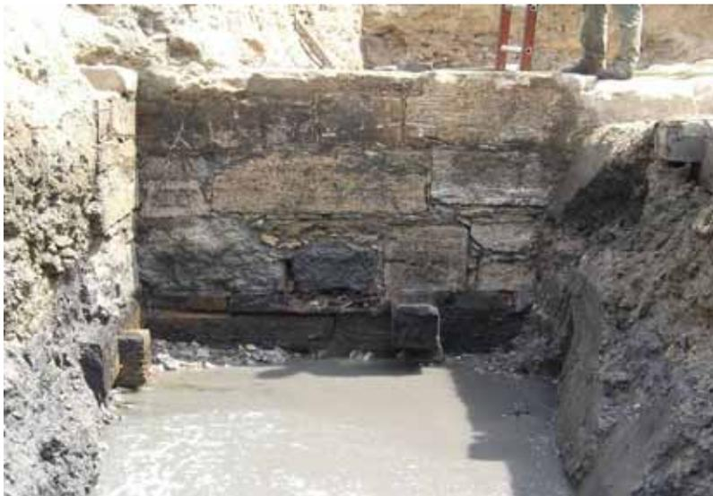
Abb. 15: Fundamentkonstruktion des Braunschweiger Residenzschlosses. Auf über 8000 Eichenholzpfählen mit waagrecht verzimmerten Schwellen kamen drei bis vier Steinfundamentschichten zum Liegen.
