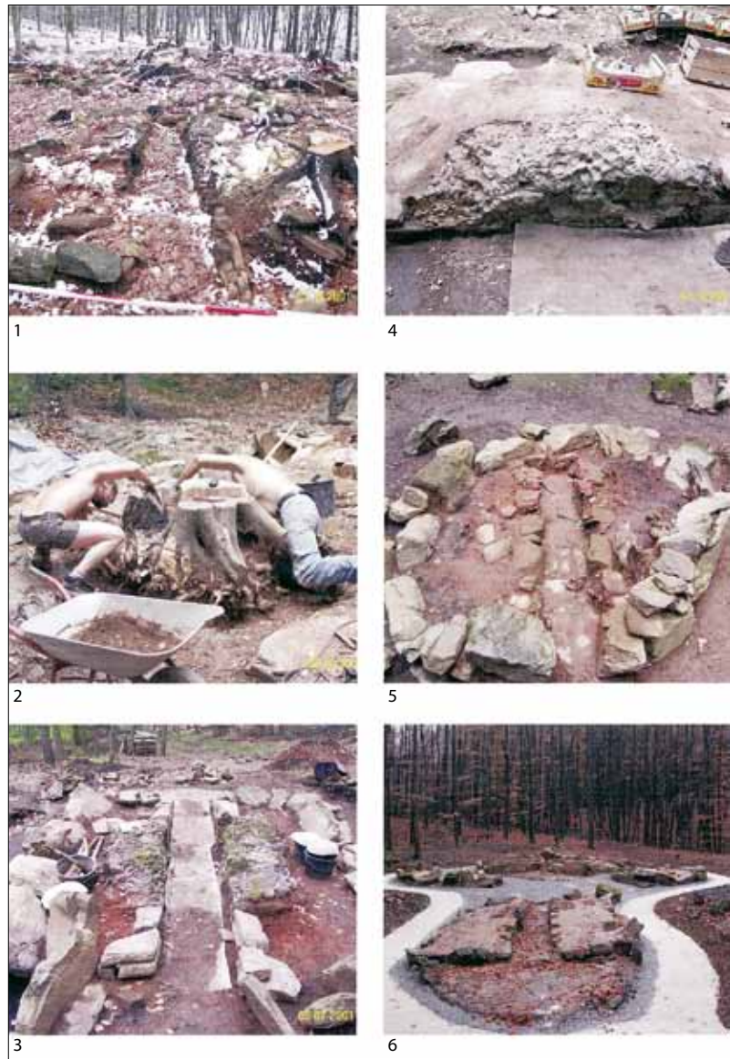
Abb. 5: Glashütte „An der Emsbachschlucht“, Gemeinde Glashütten im Taunus, Arbeitsfotos. 1: Projektübernahme: Ofen 1, im Hintergrund die Öfen 2–5; 2: Vorarbeiten: Wurzelabbau; 3: Ofen 1: Freilegung der Hafentankreste; 4: Ofen 1: Konservierung und Hinterfüllung der Hafentank; 5: Ofen 2 vor der Übergabe an den Restaurator; 6: Weganlage.
