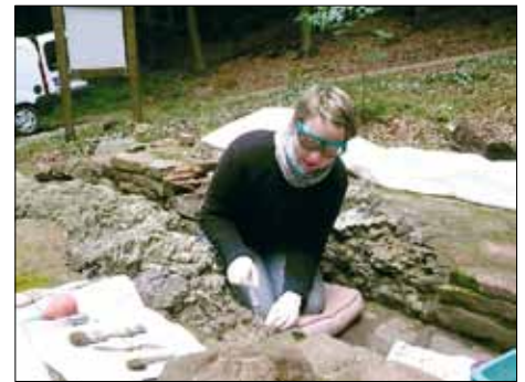
Abb. 6: Glashütte „An der Emsbachschlucht“, Gemeinde Glashütten im Taunus. Klebstoff-Injektion zur Festigung der historischen Bausubstanz.
