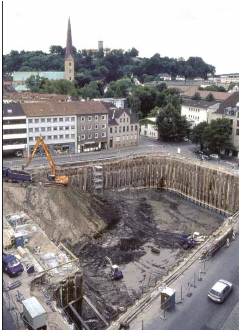
Abb. 1: Links der auf drei Seiten umbaute Grabungsschnitt. Die Baugrube hatte zum Zeitpunkt der Aufnahme die Hälfte ihrer vorgesehenen Tiefe erreicht.
