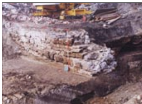
Abb. 15: Das Fundament der Domburgmauer im Süden der Domburg (Westendorf 39); Blickrichtung Nordwesten.
