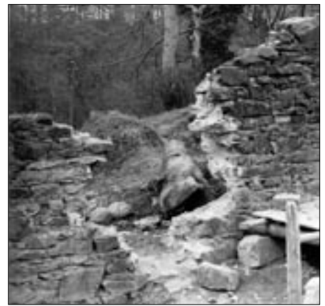
Abb. 7: Bresche in einer Mauer der Neu-Isenburg zur Zeit der Ausgrabung 1927–1932. Im Hintergrund zwei Geschosskugeln.
