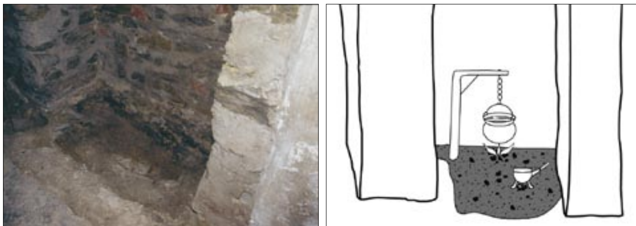
Abb. 9 und 10: Paderborn, Schildern 15. Feuerstelle in einer Nische im Keller; links Befund, rechts Rekonstruktion als Herdstelle.
