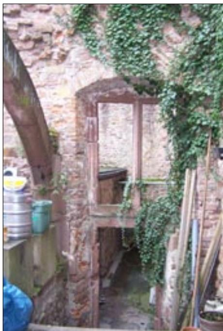
Abb. 7 (links): Schloss Heidelberg, Erweiterung der Herrenküche im Ostzwinger zwischen „Kraut“- und „Apothekerturm“. Blick von Norden auf den südlichen Gurtbogen der Hallenküche, rechts in der Südwand Oberlicht mit Tür zu den Vorratskellern im ehemaligen Zwinger (Aufnahme BDK 2005).
