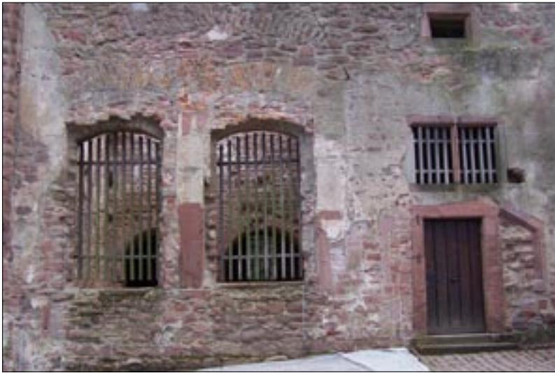
Abb. 13: Schloss Heidelberg, Westfassade des östlichen Ökonomietrakts. Gewändereste von Servierfenstern der Küchenerweiterung vor 1580, rechts von der Bildmitte vertikale Baunaht vor der ehemaligen Nordwestecke der um 1520/30 errichteten „Herrenküche“ (Aufnahme BDK 2005).
