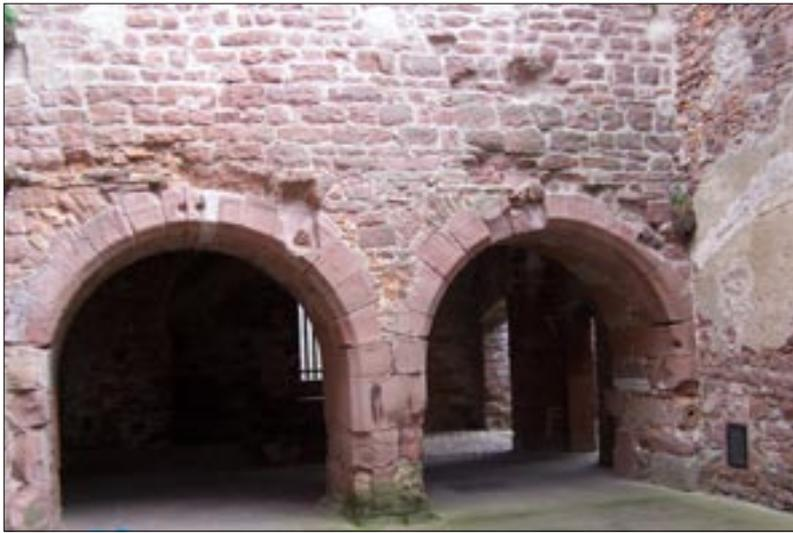
Abb. 16: Schloss Heidelberg, östlicher Ökonomietrakt. Nachträglich in die ehemalige Ringmauer der mittelalterlichen Burg eingebrochene Bogenstellung zwischen der erweiterten „Herren“- und „Ritterküche“. Bildmitte rechts: Einarbeitung für den Feuerhut der Herdstelle an der Südwand des „Ludwigbaus“, unten links in die Bogenleibung sekundär eingesetztes Wasserleitungsrohr (Aufnahme BDK 2005).
