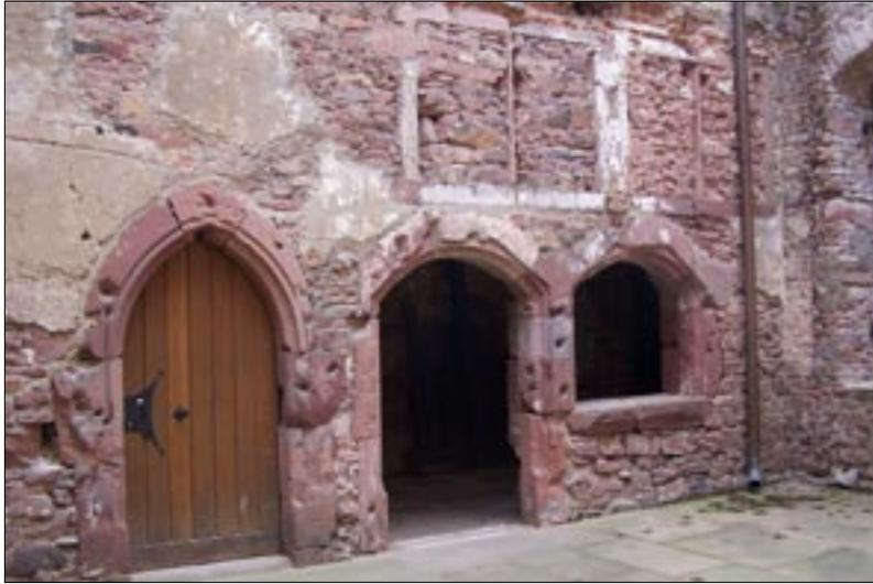
Abb. 9: Schloss Heidelberg, östlicher Ökonomietrakt. Blick von Nordosten auf die ehemalige Nordwand der „Herrenküche“. Portal mit Servierfenstern und Oberlichten der ursprünglichen Ausgabezone, rechts Stossfuge zur Süd- wand der Küchenerweiterung (Aufnahme BDK 2005).
