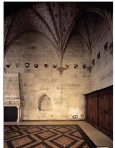
Abb. 5 (rechts): Bebenhausen, ehem. Zisterzienserabtei. Westwand des Sommerrefektoriums. Reste des romanischen Vorgängerbaus mit der vermauerten Tür zur Küche haben sich im nördlichen Bereich der Wand erhalten.
