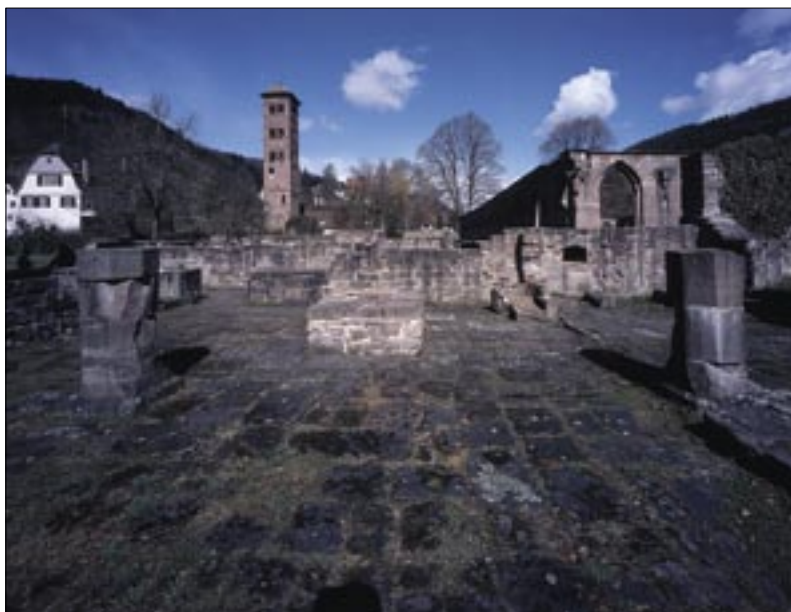
Abb. 16: Hirsau, ehem. Benediktinerabtei St. Peter und Paul. Blick in die Ruine der 1531 wiederaufgebauten Küche. Im Zentrum ist der gemauerte Herd zu erkennen, rechts dahinter der kleine freistehende Backofen.
