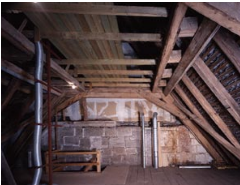
Abb. 15: Bebenhausen, ehem. Zisterzienserabtei. Dachraum des Küchenbaus mit Blick nach Osten. An der Westwand des Sommerrefektoriums Ansatzspuren des Küchenbaus aus dem 14. Jahrhundert. Die beiden Wechselbalken in Höhe der Kehlbalken zeigen die Dimension des Kuchenschlots der frühneuzeitlichen Küche.
