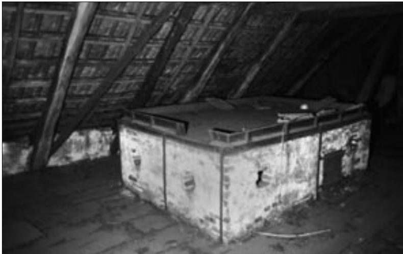
Abb. 4: Auf dem Dachboden des Gasthauses Markt 6 in Telgte (Kr. Warendorf) hatte sich bis 1992 eine wohl in der Mitte des 19. Jahrhunderts angelegte Malzdarre erhalten, in der das Braugetreide für das erst 1915 eingestellte Hausbrauen hergestellt wurde.
