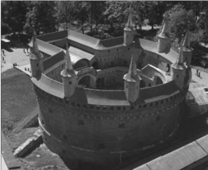
Abb. 14: Krakau. Barbakane nach der Restaurierung im 19. und 20. Jahrhundert.
