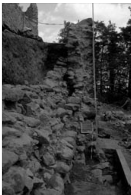
Abb. 3: Südwestliche Zwingermauer mit Vorblendung und Brüstungsaufsatz.
