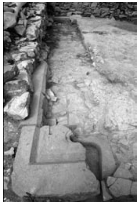
Abb. 6: Die Detailaufnahme zeigt die Reste des Bodenbelags in der Südostecke der unteren Brunnenanlage während der Freilegung. Gut zu erkennen ist die runde Abarbeitung zur Aufnahme eines Überlaufrohrs mit dem darunterliegenden Ablauf. Die V-förmige Nut am Rand der Platte diente zur Aufnahme der Steinblöcke, die die Wandung des Beckens bildeten (Foto: M. Preißler).
