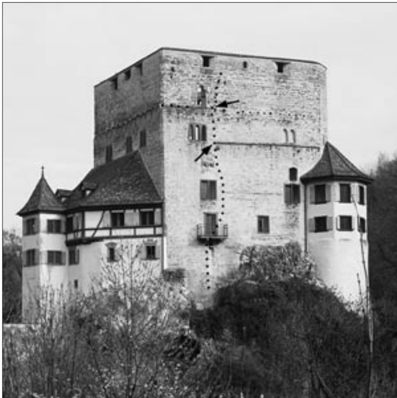
Abb. 1: Duggingen, Ruine Angenstein von Süden. Gepunktet die Abbruchlinie der im Basler Erdbeben von 1356 eingestürzten Partie.
