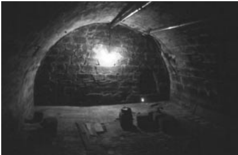
Abb. 3: Hohes Tonnengewölbe unter dem Gasthaus »zum Schwan«, Christoph-Sturm-Straße 5
