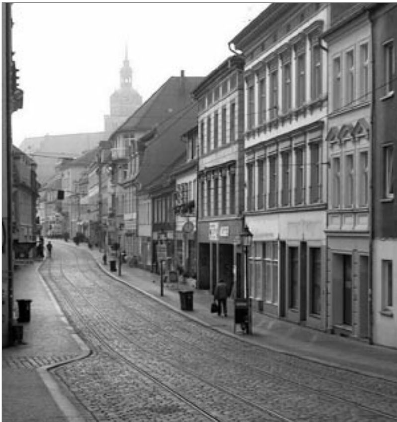
Abb. 1: Brandenburg an der Havel, Neustadt. Blick durch die Hauptstraße in Richtung Katharinenkirche. Abfolge bürgerlicher Grundstücke unterschiedlichen Alters. Im Vordergrund die erst seit dem Spätmittelalter entstandenen Anwesen in der Vorstadt »Venedig« mit geschlossener Bebauung des 18. und 19. Jahrhunderts. Im Hintergrund Parzellen des 13. Jahrhunderts.
