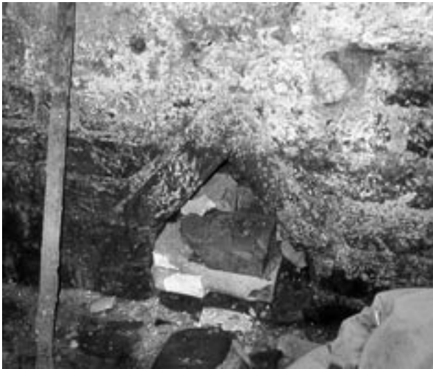
Abb. 10 (links): Leuchternische mit Winkelsturzabschluss im Keller Frankenstraße 42. Abb. 11 (rechts): Leuchternische mit getrepptem Abschluss im Keller Ossenreyerstraße 14.
